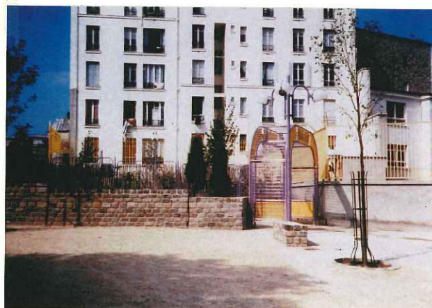
建設中の公園。スマイレ色の街具が目立つ。
