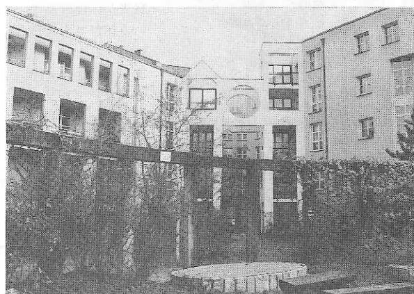
“心の庭”と名付けられた中庭より中央の中庭をみる。 連結部は吹抜けになっており自由に行き来できる。
