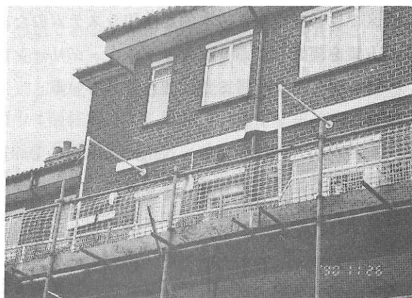
バルコニーの取り付け工事
