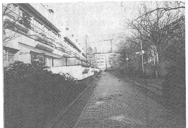
地上部の中央通路 左側が一階居住者の専用庭、前面の植え樹はプライバシー保護の機能も兼ねている。
