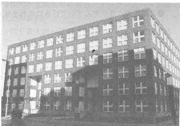
* ケッテナー街路
