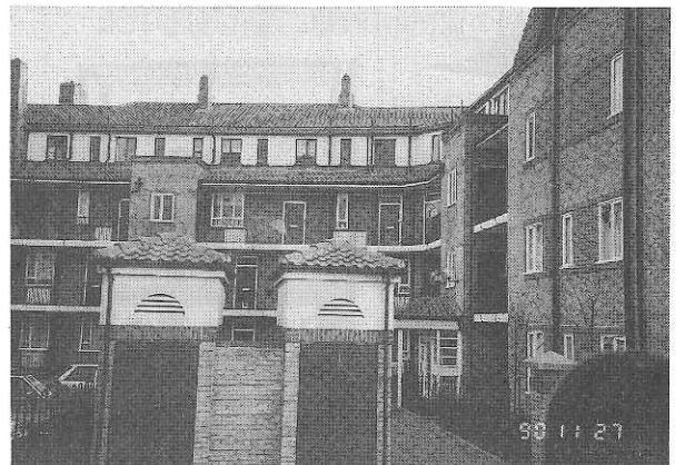
住棟と同じ仕上げのゴミ収納室
