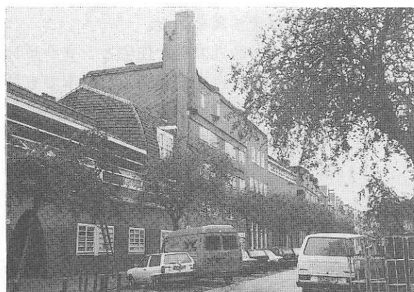
街路からみた南側の棟。左端のアーチから住棟アクセスのある中庭へと続く。
