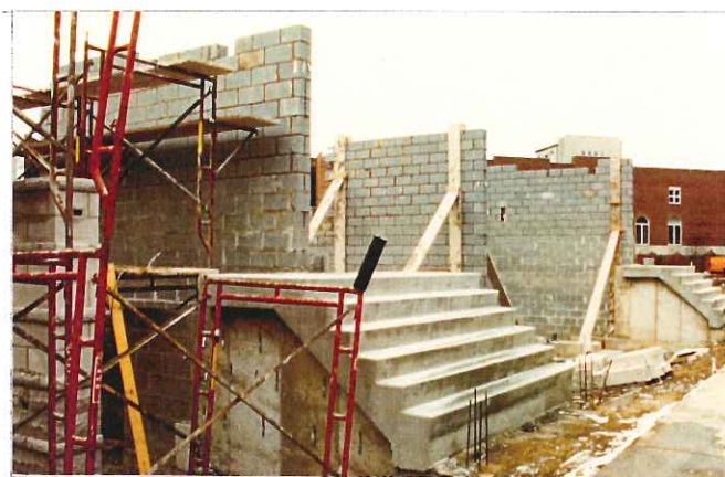
1) 基礎及び界壁のコンクリートブロック工事
