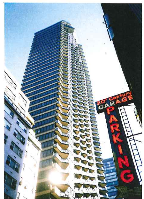
南側に三角形のオープンバルコニーがある。
