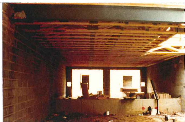
2) 木製トラスを界壁間に架け床組みを構成する
