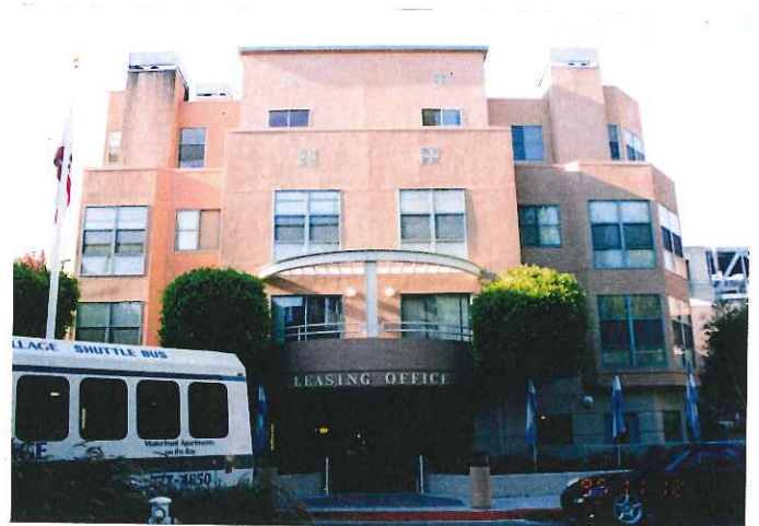
リーシング・オフィス外観
