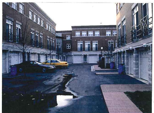
中庭は車路空間となっている
