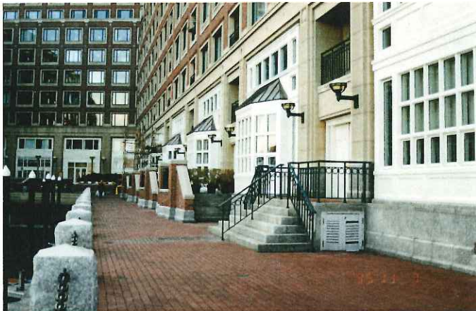
水際との優しいつながり。住戸のプライバシーも確保されている。
