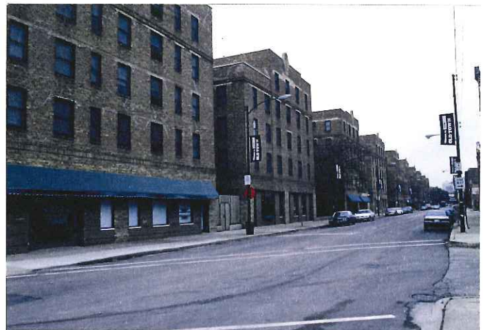
住棟間スリットが長大な壁面を和らげる
