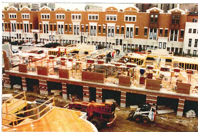
5) 住戸内のフレーミングを行っている
