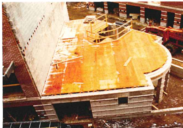
3) 木製トラスの上に合板を敷き床面をつくる
