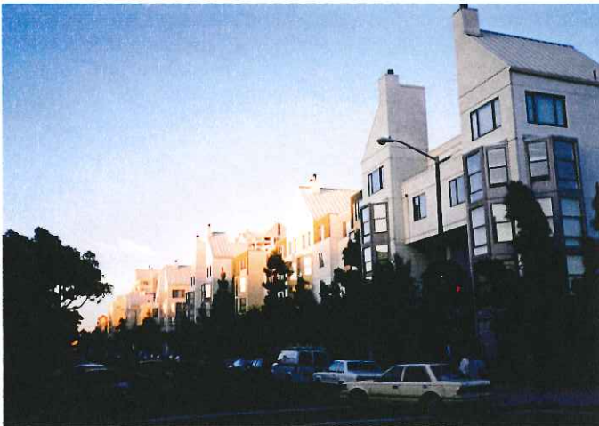
★街路沿いに家並み演出しながら、新しさを感じさせる勾配屋根デザイン。
