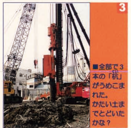
2 ■どんどん「杭」が地面に埋められていく。掘り出されたやわらかいドロドロの土をパワーシャベルでうけとめている。
