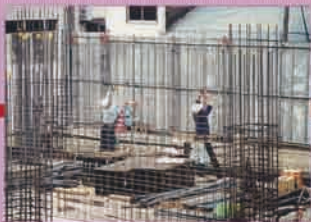
はいきん ねむく 配筋 (骨組み)
