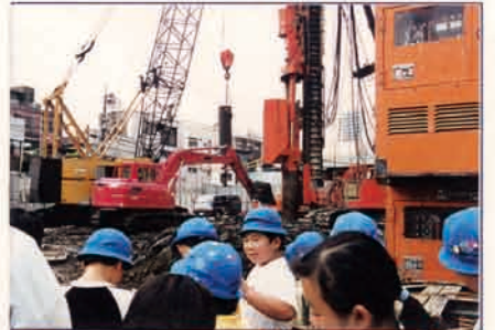
2 ■どんどん「杭」が地面に埋められていく。掘り出されたやわらかいドロドロの土をパワーシャベルでうけとめている。
