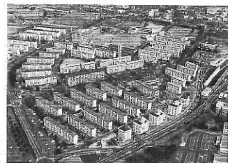
手前が東京外環状自動車道
