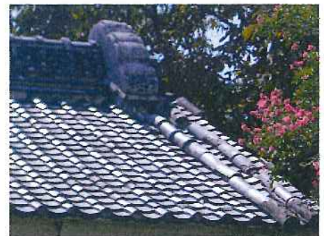
丸瓦の多くがズレ、破損している 北面西側
