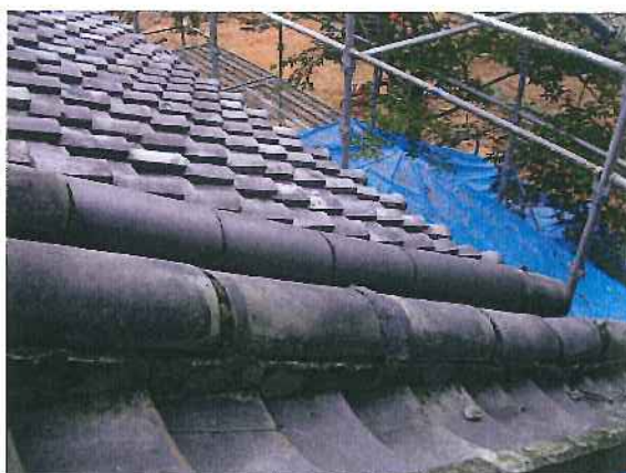
のし丸瓦の補修
