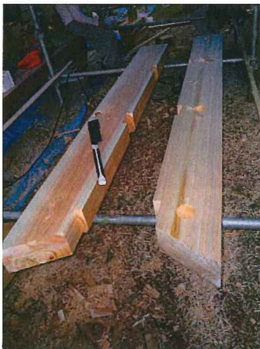
2階床の補強梁(階段取り合い部用) 既存梁抱き込み用のボルト孔、 根太落とし込み用のかき取り加工
