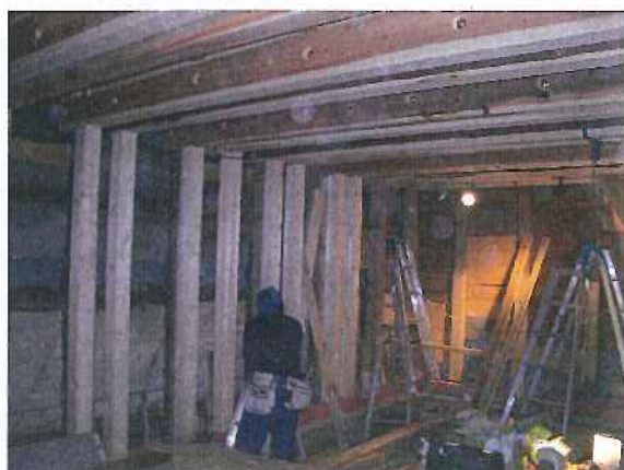
補強梁と一体に補強柱の建て込み
