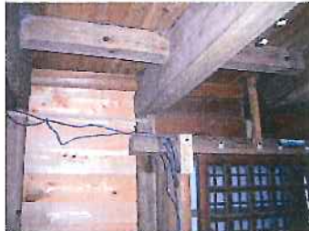
2階床梁、根太～白蟻被害により腐朽
