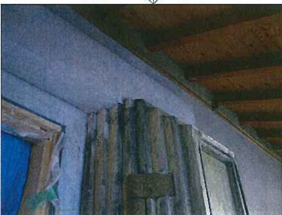
モルタルによる下地修復(のうえで漆喰による仕上げ)
