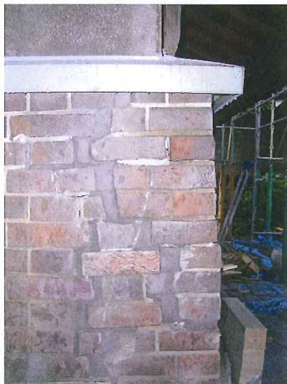
煉瓦積みの割れ部分に無収縮モルタルの充填
