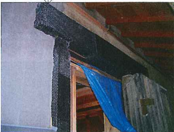
ラス、防水紙張り
