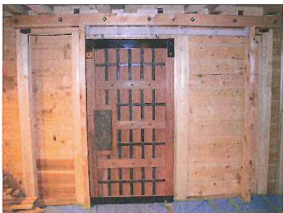
板戸内観 吊り引き戸に改良
