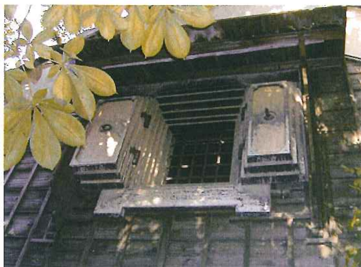
西側窓(平成16年)
