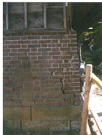
2011.3.11東日本大地震以降、 大きく進行したブロック積みのクラック
