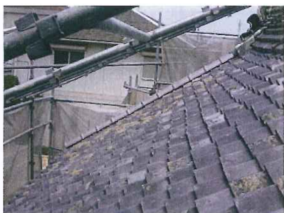
瓦のずれ落ちの手直し
