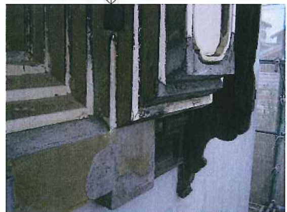
モルタルにより下地修復
