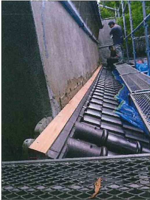
下屋部の屋根～壁取り合い部分に 水切り用下地取り付け
