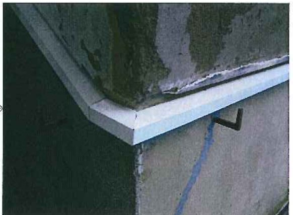
見切り材の取り替え～ガルバ鋼板加工
