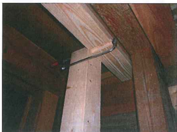
補強柱は補強梁取り付け後に建て込み
