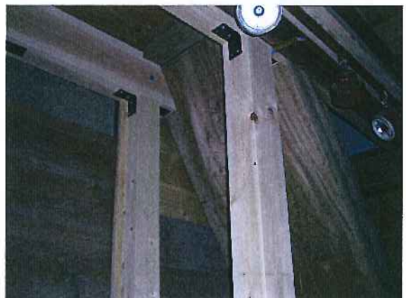
補強柱間に壁板のはめ込み
