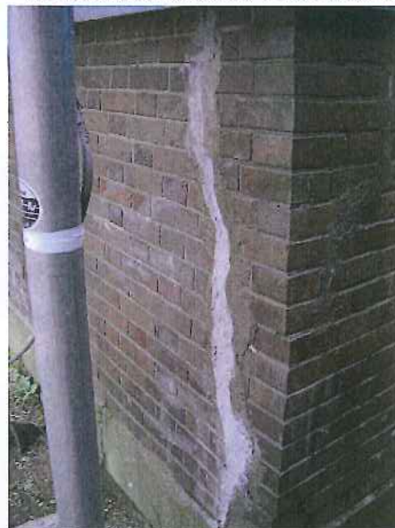
無収縮モルタルの充填
