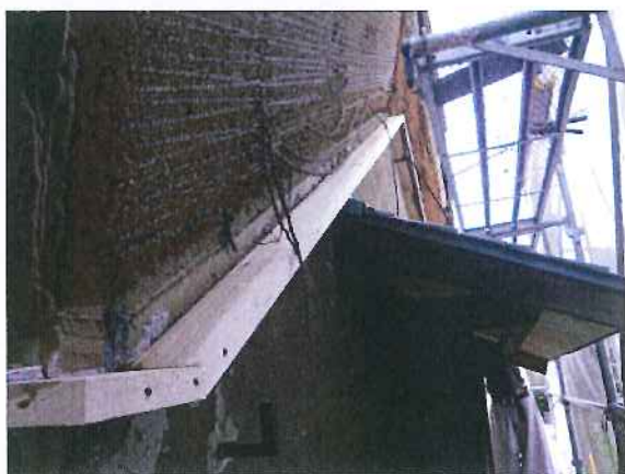
破風部分見切り材(前頁)の下地材取り付け
