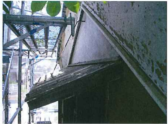
既存トタン及び野地板の撤去
