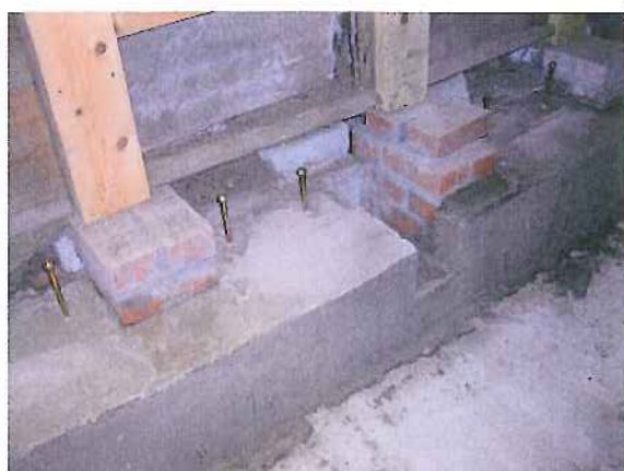
アンカーボルト(補強柱脇)
