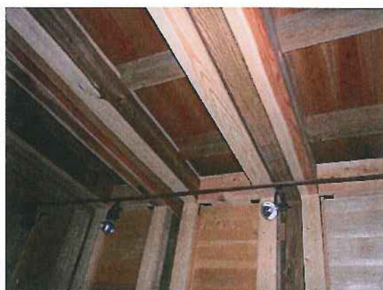
寄贈の木下の杉を使った補強添え梁
