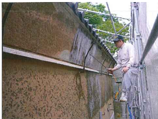
荒木田土下地の上にプライマーを塗布 (中塗り下地との接着性)
