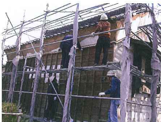
下見板撤去作業
