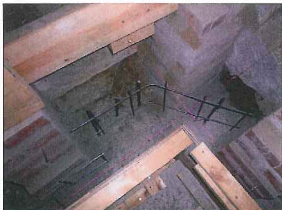
補強柱用基礎の配筋(D10@200程度)
