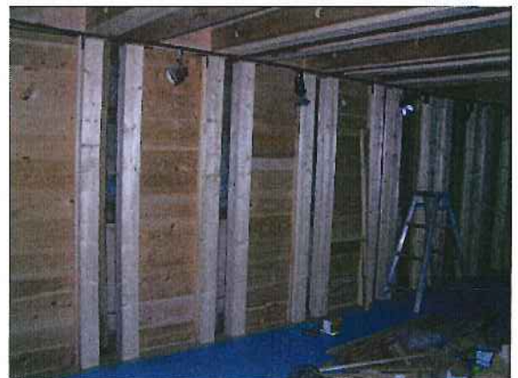
補強柱間に壁板のはめ込み
