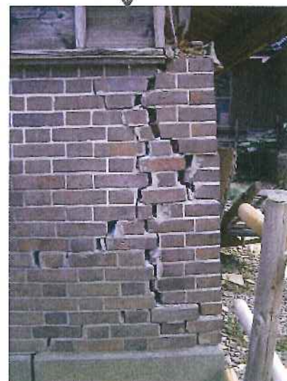
2011.3.11東日本大地震以降、 大きく進行したブロック積みのクラック
