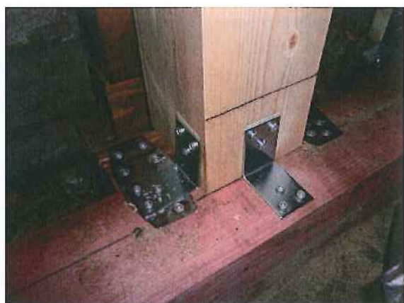
注入土台(CB)敷き込み、金物止め(ほぞ差し不可)
