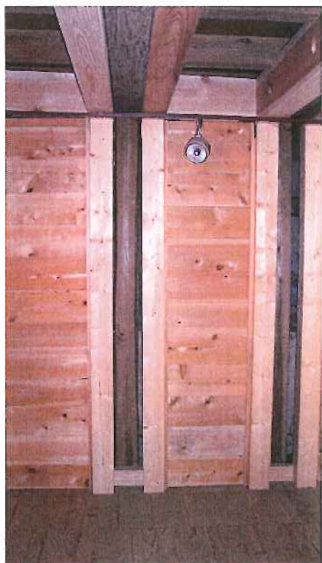
北面の補強添え柱及び補強添え梁
