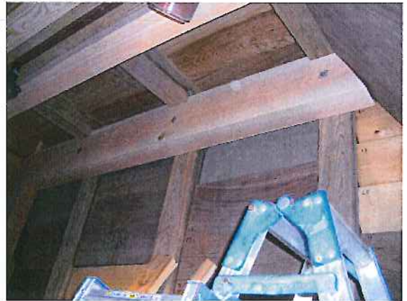
補強梁はボルト締めにより既存梁及び柱に取り付け
