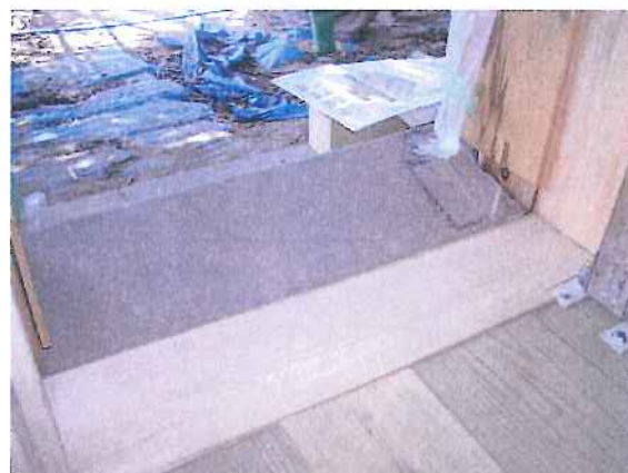
出入り口沓刷り石が転んでいるため この上に 御影石敷込み
