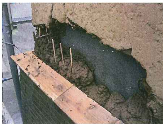
漆喰下地の崩落部分は再利用の荒木田土により 最下層下地の塗り替えを行った。
