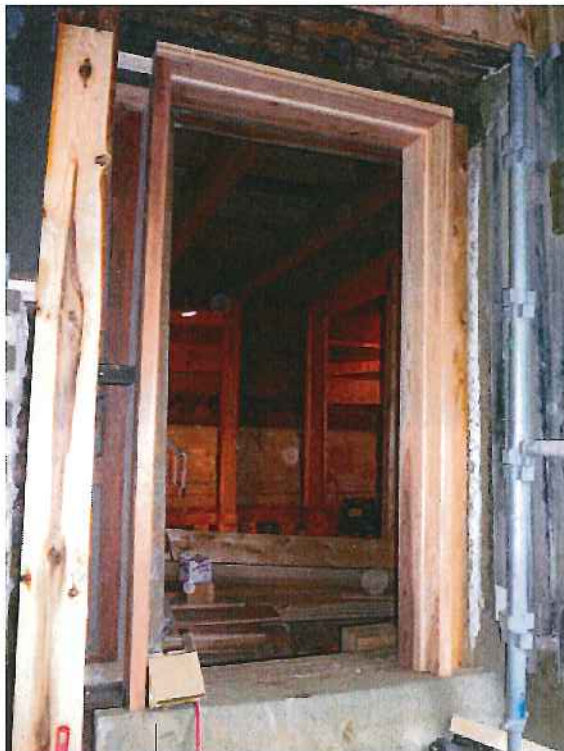
まぐさ受け柱の取り替え、 開口枠材の取り付け
