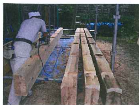
支給材(梁)の加工
