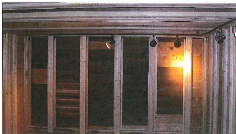
西面の補強添え柱及び壁羽目板張り(一部既存再利用)
