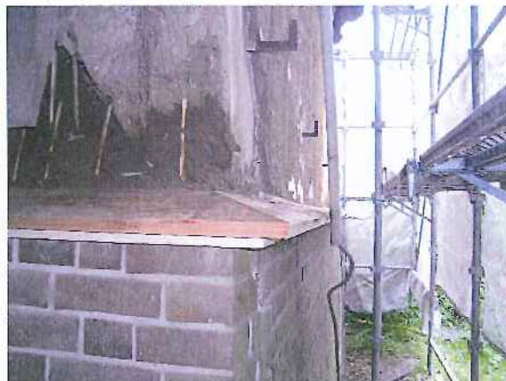
煉瓦積み部分上部水切り下地の取りかえ
