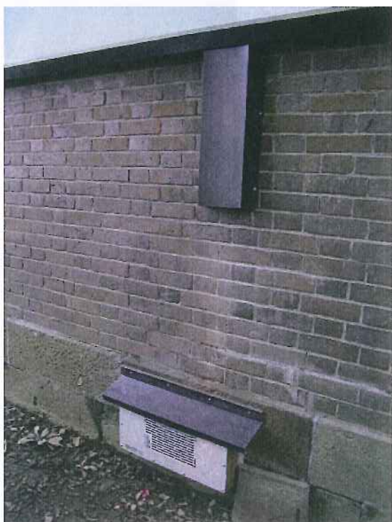
下部: 床下換気扇とコントロールボックスを鋼板材で保護
