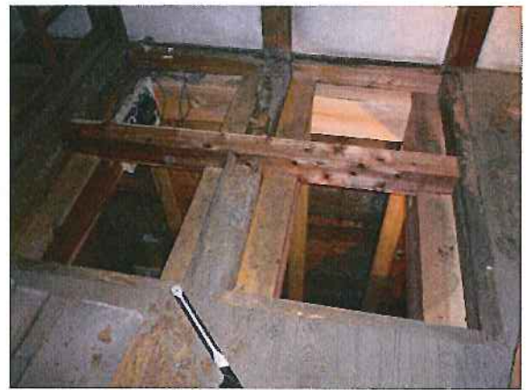
2階の一部腐朽した根太は取り替え
